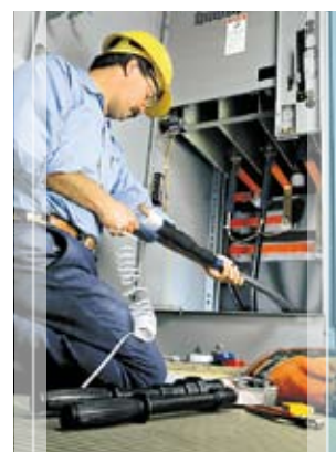
Montáž staniční koncovky
