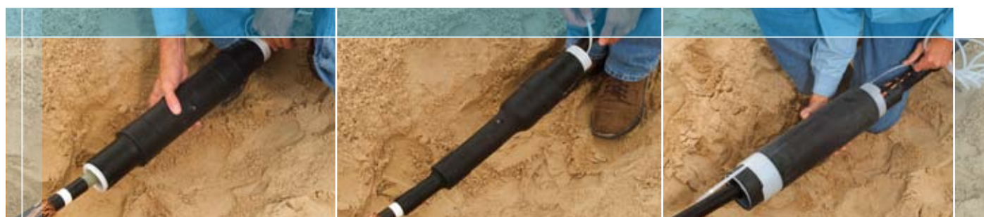
Nasazení vnitřní trubice
